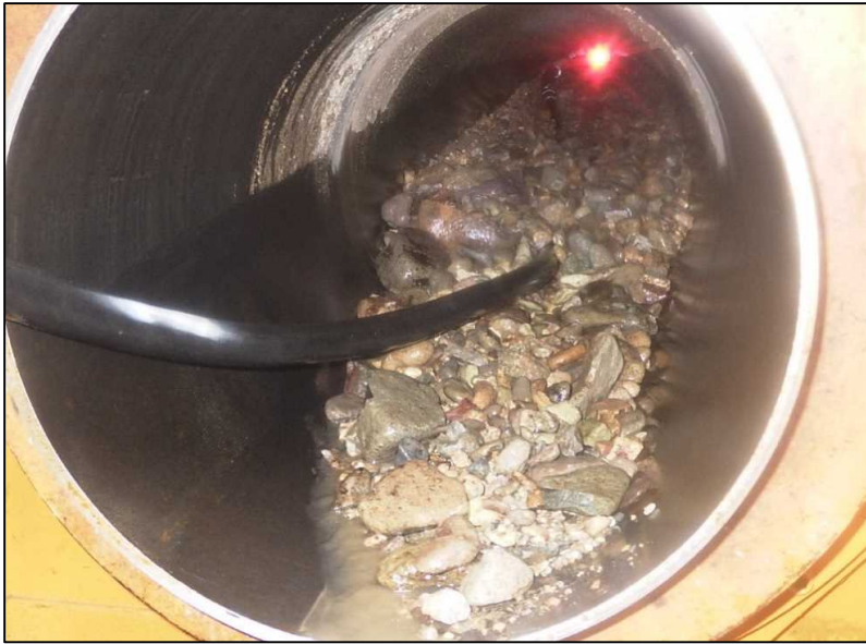
掘削残土取込状況
